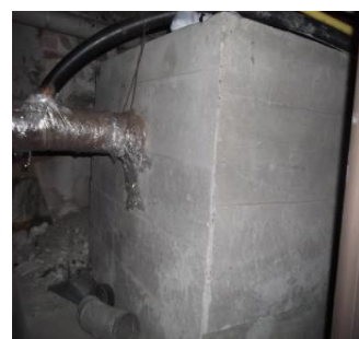
Au sous-sol de la maison
